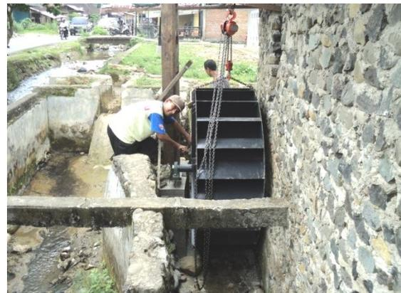
Gambar 5. Pemasangan *Runner* Kincir di Lokasi Pengujian menggunakan Takel/ Katrol.
